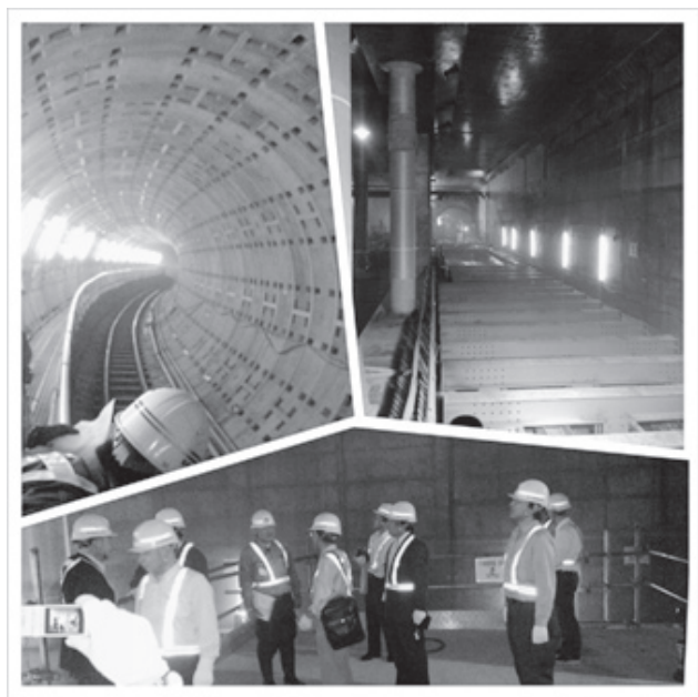
仙台市営地下鉄工事現場の視察
